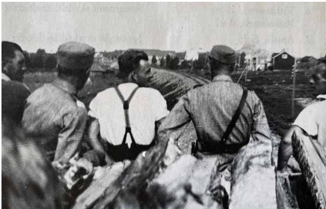
Alarik avverkade under sina 129 resor från midsommaren 1941 till senhösten 1944 sammanlagt 165 577 km, en sträcka som motsvarar drygt fyra färder jorden runt vid ekvatorn.
